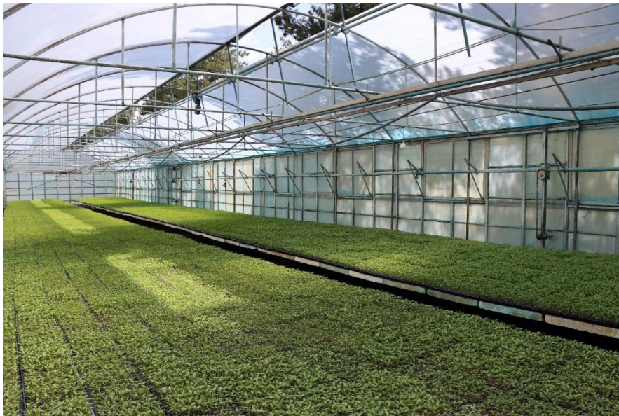
Resim 19.Erzincan Bahçe Kùltürleri Araştırma Enstitüsü Fidesi Üretim Serası
